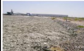
Problemas de saturación de lodos, grasa, DBO
