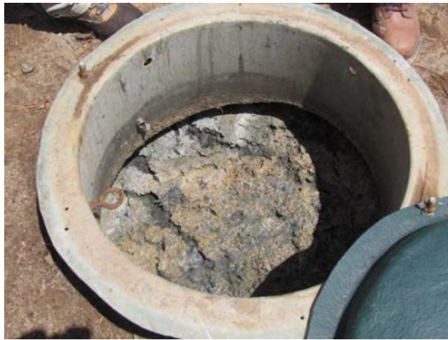
Grasa en el tanque primario.
