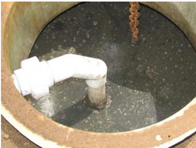
Grasa en el tanque primario.
