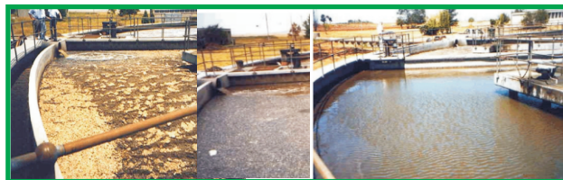
Aplicando M205 y M100 en 3 semanas se estabilizo
